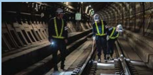
夜間トンネル工事
