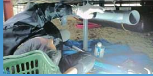
床下配管作業に
