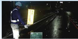
夜間土木作業
