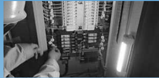
分電盤工事に
